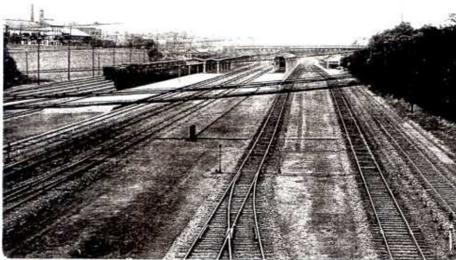
右側に給水塔が建っている
