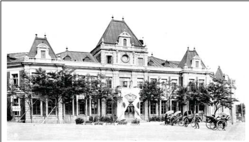
日本占领时期的达里尼市政厅
